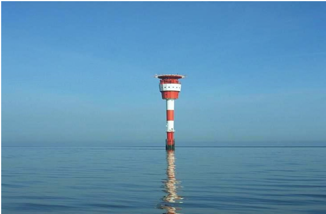
rot-weiß gestreifter, runder Turm mit viergeschossigem Aufbau, Hubschrauberlandeplattform und angestrahlem Schaft
